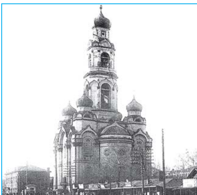
«Большой Златоуст». Взорван на перекрестке улиц Малышева и 8 Марта в 1930 году. Восстанавливается
